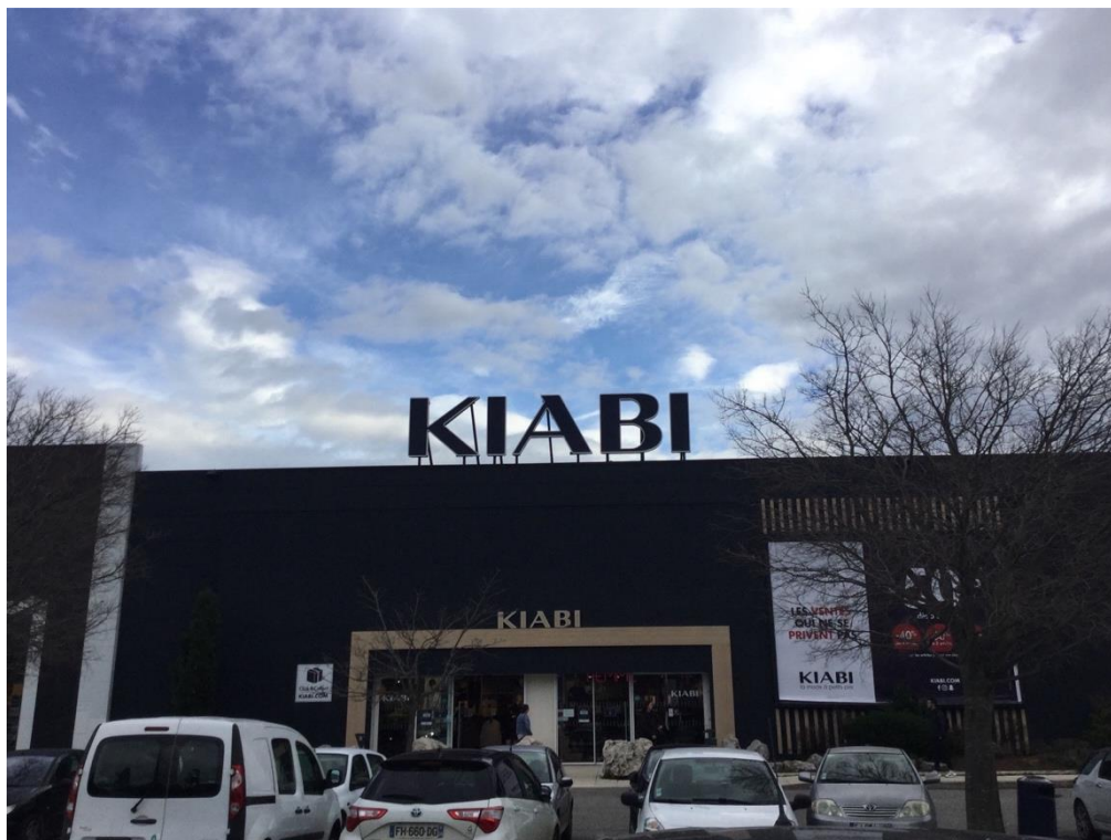
Exemple d'enseigne sur toiture ou terrasse en tenant lieu, exemple non prise sur La Buisse.
